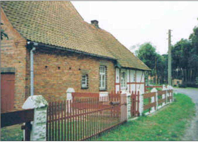
Haus von Wanda und Walter Fehrendt wird umgebaut
