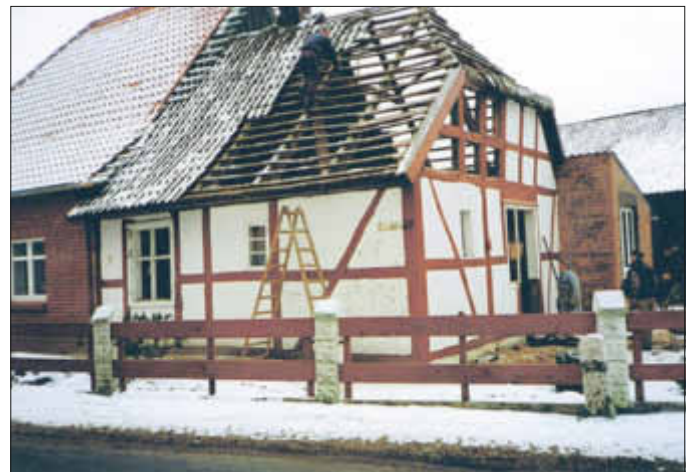
Haus von Wanda und Walter Fehrendt wird umgebaut
