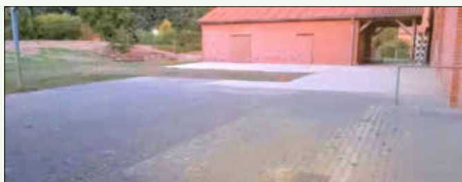
Neue Pflasterung hinterm KUK
