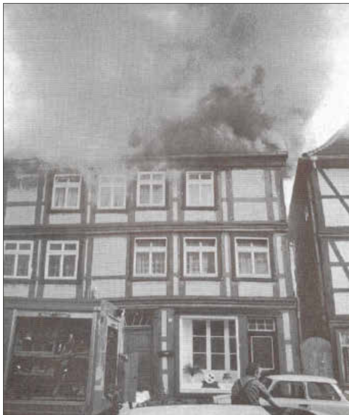
Dachstuhlbrand in der Marktstraße
